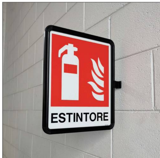
INSTALLAZIONE DI SEGNALI BIFACCIALI
