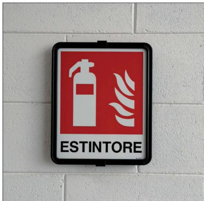
INSTALLAZIONE DI SEGNALI MONOFACCIALI
